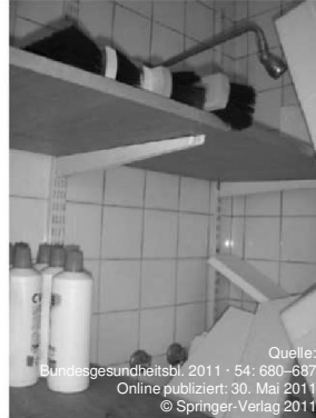
Abb. 5 ▶ Kein bestimmungsgemäßer Betrieb einer Dusche
